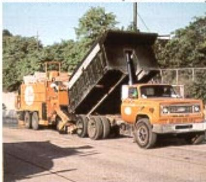
bajo desgaste del firme. Los áridos del tipo II son los que se emplean más comúnmente y ampliamente, en donde el tráfico es de moderado a pesado. Estos áridos del tipo II sellan, corrigen/desmoronamientos moderados y graves, oxidación del ligante y pérdida de finos y mejoran la resistencia al deslizamiento. El tipo III corrige los desperfectos graves del firme—obviando el acuaplaning y proporcionando propiedades anti-deslizantes bajo condiciones de tráfico muy pesadas.
